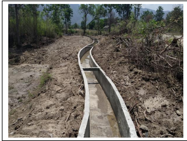
โครงการ ก่อสร้างรางรินคอนกรีตเสริมเหล็ก (สายวังตันตุ้ม) ขนาด กว้าง 0.80 เมตร ลึก 0.60 เมตร หนา 0.10 เมตร ยาวรวม 300.00 เมตร สถานที่ดำเนินการ บ้านทุ่งรวงทอง หมู่ที่ 12 ต.สบปราบ อ.สบปราบ จ.ลำปาง งบประมาณ 495,000 บาท
